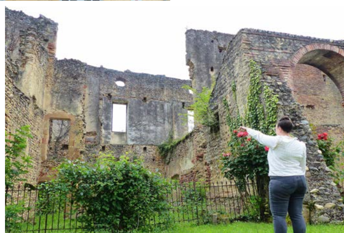
Plusieurs parties du bâtiment, comme ici les ruines, seront restaurées ou consolidées dans le cadre de chantiers d'insertion.
